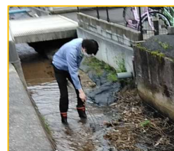
＜上井工場＞ 水路の清掃
